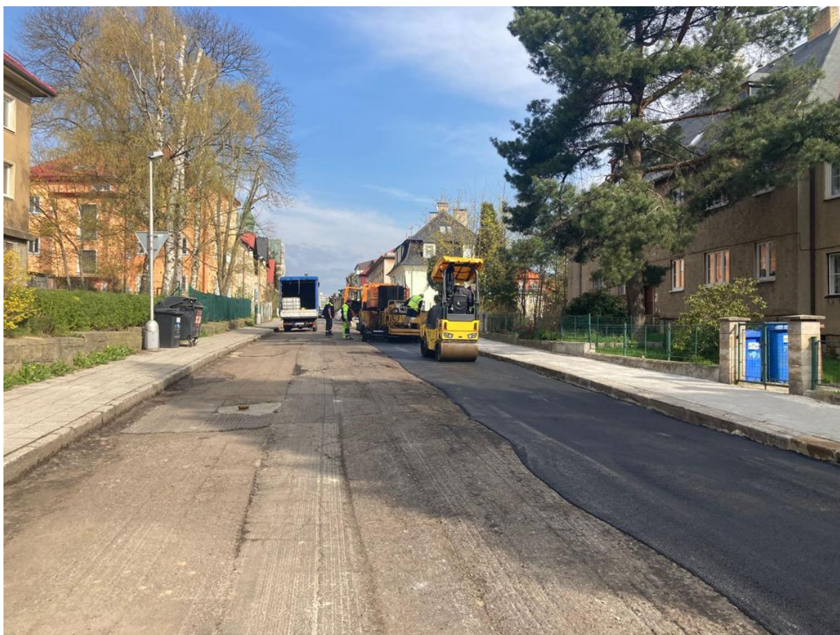
Ilustrační foto: Pokládka nového povrchu
